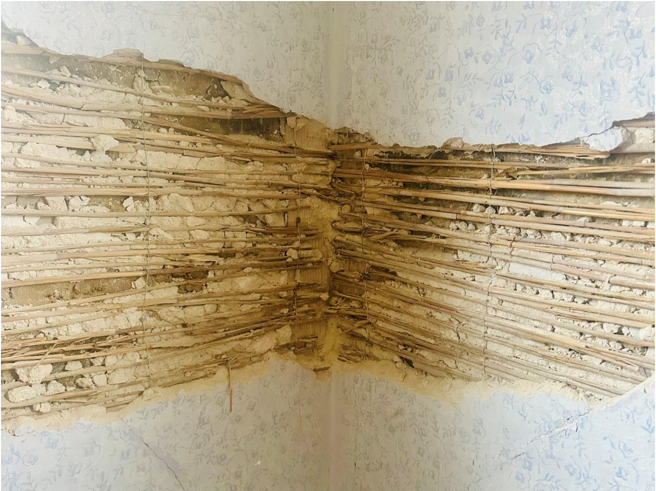
Sanierung im Prozess, Lehm im Umgebnde ©EM
